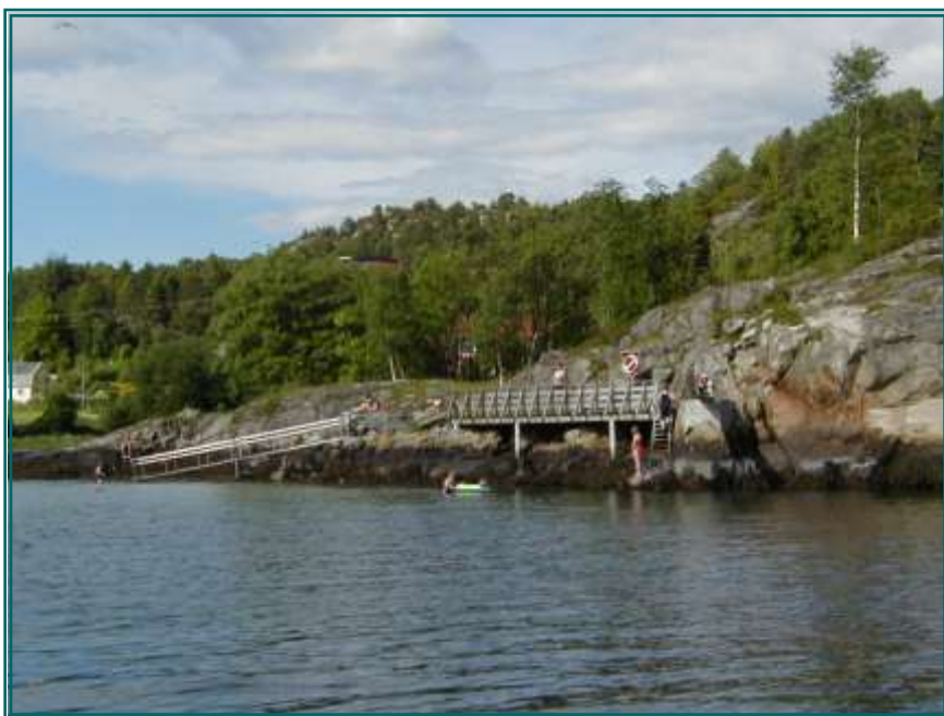
Oversiktsbilde fra Lislevika, med tilrettelagt rampe og fiskeplass.
